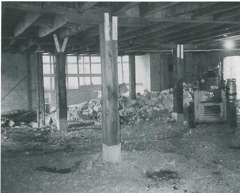
*Nouvelles bases de béton pour colonnes de bois.*
