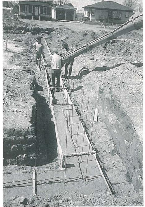
*Mise en place du béton des empattements. On distingue la clé et les tiges d'armature.*
